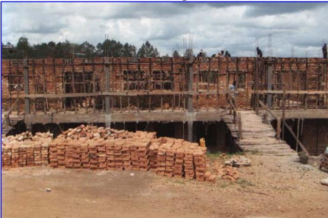
Steine und Materialien werden z.T. auf dem Kopf oder mit Schubkarren transportiert
